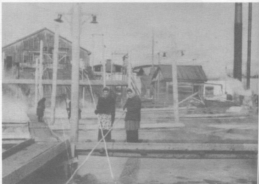
77. Baseinas, iš kurio atšildyti rąstai perduodami į lentpjūvę
